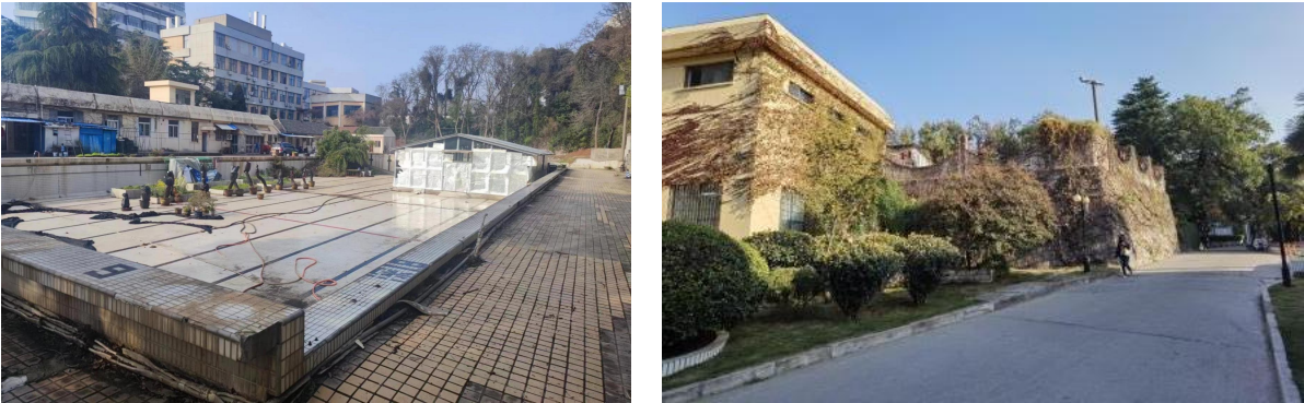
图 2.2-1 运动场配套用房（地下车库）场地现状图
